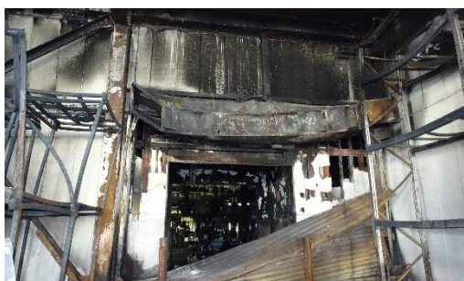
図 3-32. 西側防火シャッターの状況
