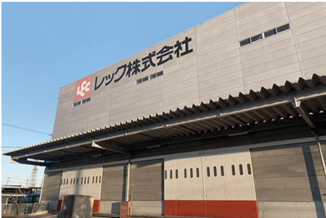
図2-5 発災以前の静岡第2工場（北側部分を撮影）
