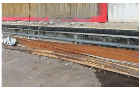
図3-37. 8月18日に事故調査員が現場調査で確認した東側防火シャッター写真と模式図
