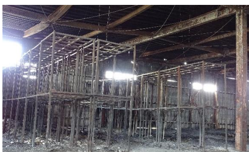
図 3-40. 製品保管棚の状況
