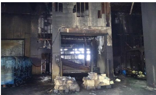
図 3-26 ⑩西側防火シャッター付近
