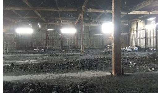
図 3-45 中央部は陥没している
