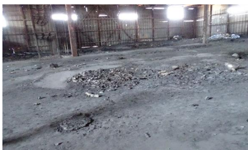
図 3-42. 倉庫中央部は陥没している
