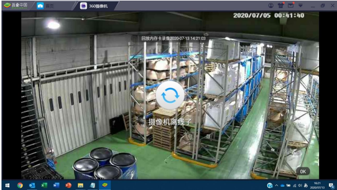
図 2-34 1 階北側倉庫での原材料および資材の保管状況（倉庫内北側）
