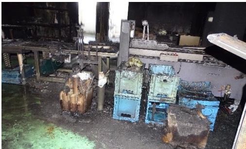
図 3-29 搬送機の焼損状況
