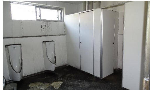
図 3-23 ⑦焼損が見られない西側トイレ
