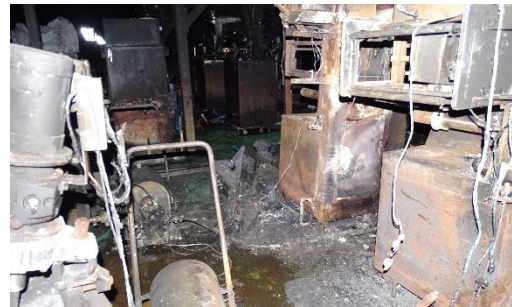
図 3-30 液ピロー機の焼損状況
