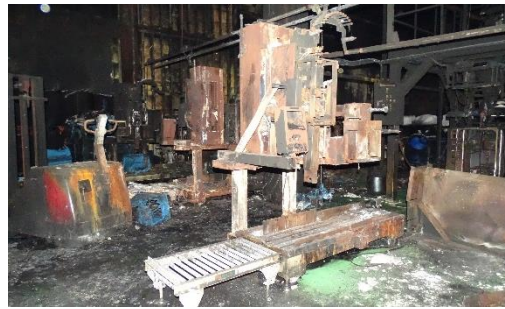
図 3-17 ②焼損した機械設備
