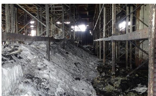
図 3-34. 北側原材料保管棚の状況
