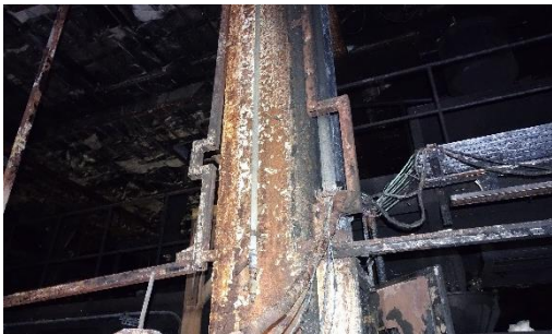
図 3-18 ②焼損が激しい東から 2 番の柱
