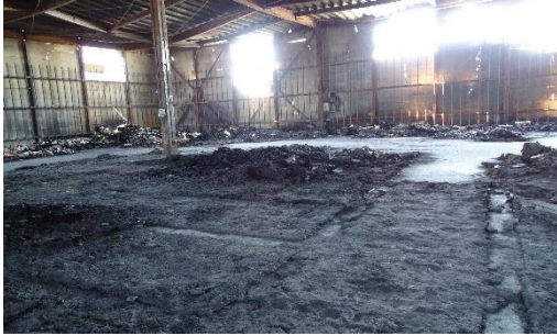
図 3-44 2 階南側倉庫の状況
