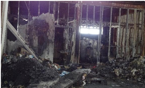
図 3-46. トイレ室の状況
