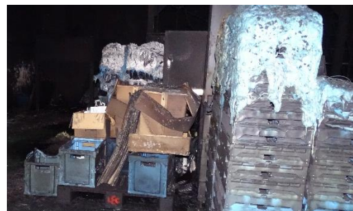
図 3-27 ⑪上部が融解した資材の状況
