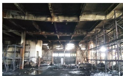
図 3-35. 大きく歪んだ天井の状況
