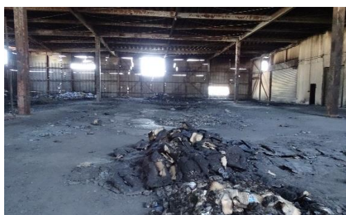
図 3-41. 保管していた製品の焼損状況
