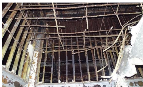
図 3-33. コンプレッサー室内
