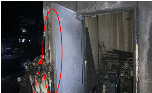
図 3-24 ⑧中央階段室扉の状況 階段室扉のラッチがある面が煤で覆われている。 自閉式の扉は火災中に開放された可能性がある。
